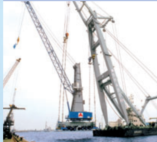
Das Versetzen eines Gottwald Krans innerhalb eines Hafens per Schwimmkran
