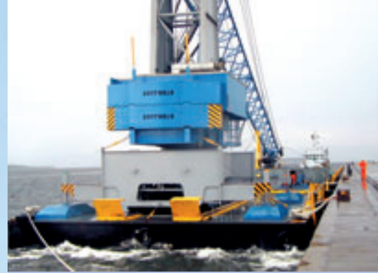
Krantransport über eine kurze Seestrecke in ruhigen Gewässern mittels Barge
