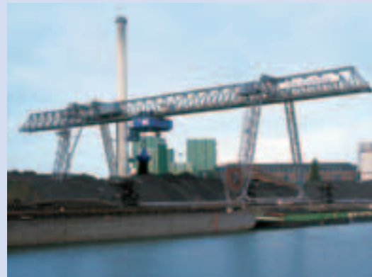
Fachwerkportalkran WSG beim Kohleumschlag im Hafen von Aschaffenburg
