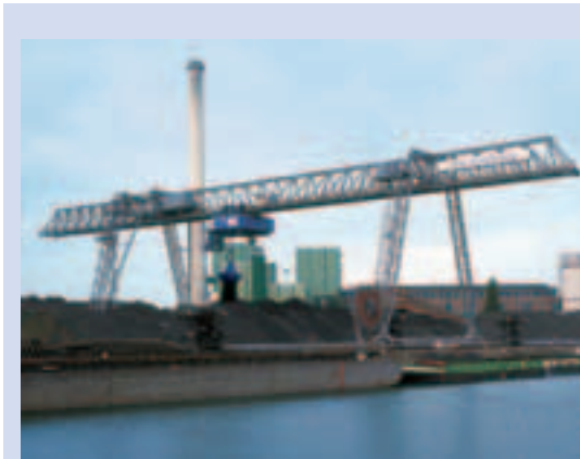
Grua-pórtico treliçada WSG em actividades de carga e descarga de carvão em Aschaffenburg, Alemanha
