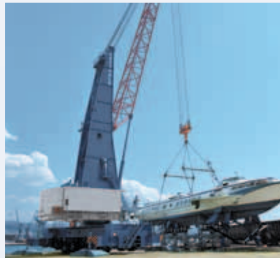
Gruas com balde de quatro cabos HMK 260 EG da Gottwald elevando cargas pesadas em Tessalónica, Grécia
