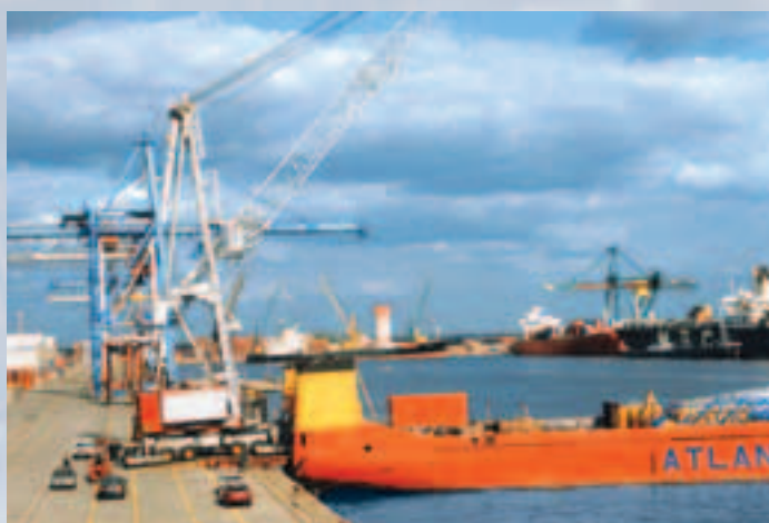
Transporte, montaje y puesta en servicio de grúas en todo el mundo
