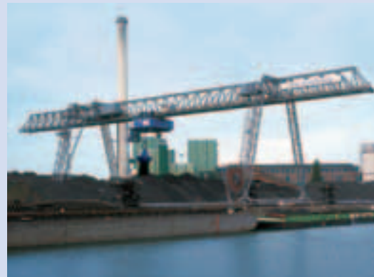
Grúa pórtico de celosía WSG durante el transbordo de carbón en el puerto de Aschaffenburg, Alemania
